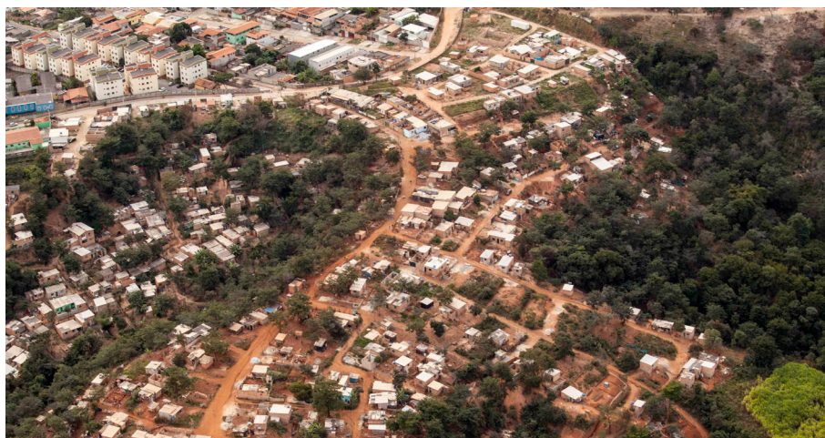
Figura 2 – Vista aérea parcial da ocupação Rosa Leão, com a cidade legal ao fundo, destaque para as diferenças de áreas permeáveis e de cobertura vegetal entre a ocupação e a cidade legal. Fonte: Escritório de Integração, (2016).
