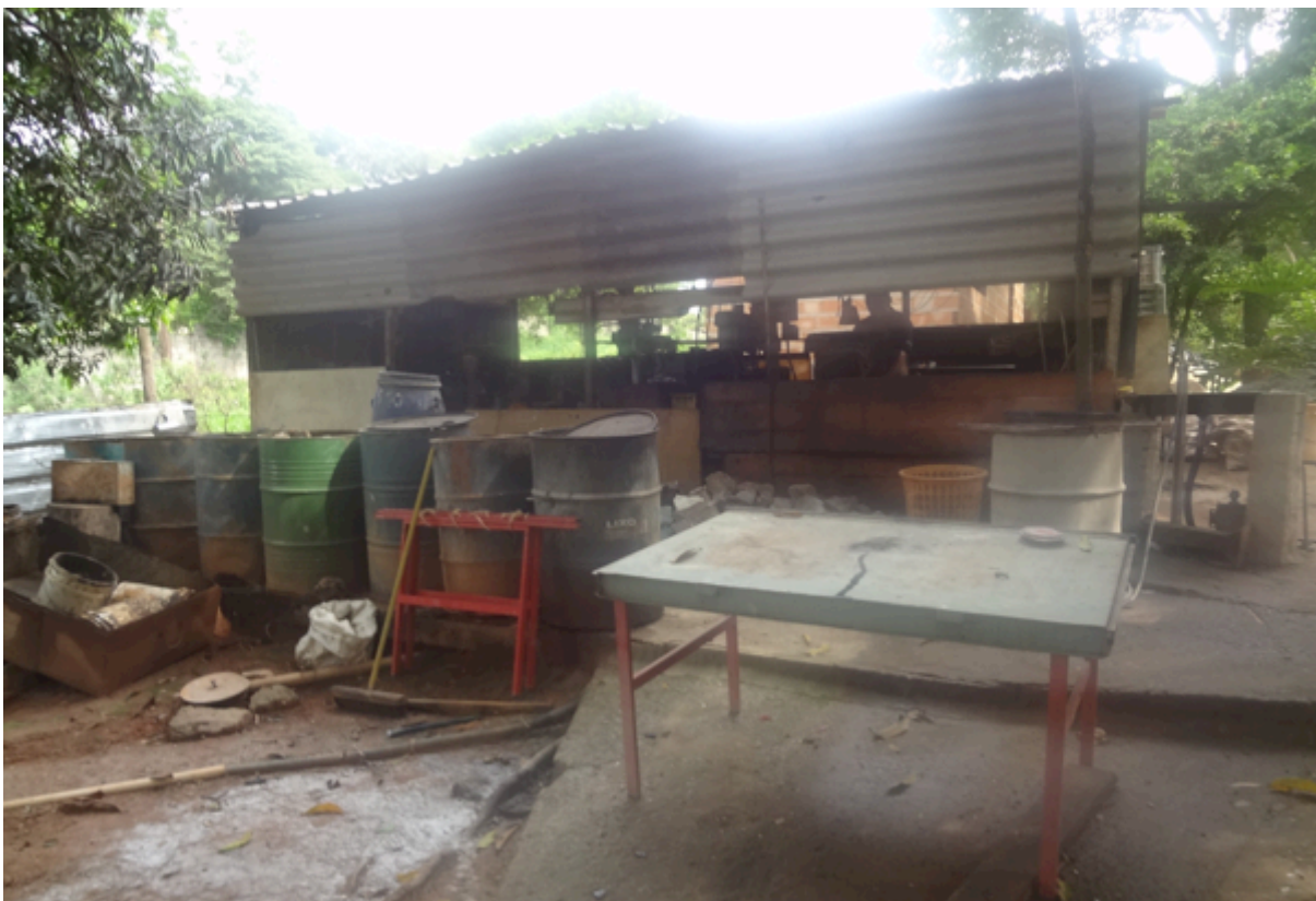
FIGURA 50 – Vista do galpão construído com recursos disponíveis
