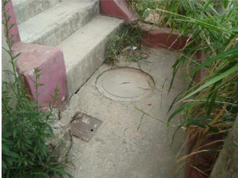
Figura 39 - Urbanização da área, recalque em pavimento de via de pedestre - Beco Cartola (10/09/2013).
