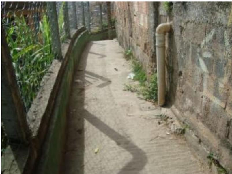
Figura 28 - Conflitos nas áreas urbanizadas, Ligação predial de esgoto sanitário aparente em beco urbanizado - Beco Mendes (10/09/2013).
