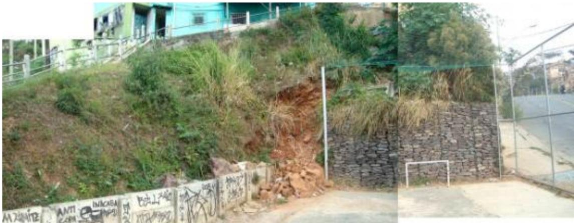
Figura 42- Urbanização da área, contenção e talude construídos em processo de ruína - Beco Sérgio Buarque (10/09/2013).
