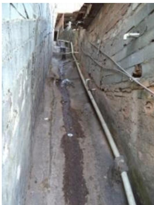
Figura 27 - Conflitos nas áreas urbanizadas - canaleta de drenagem com tubulações de esgoto sanitário e de abastecimento de água - Rua Rui Guerra (10/09/2013).
