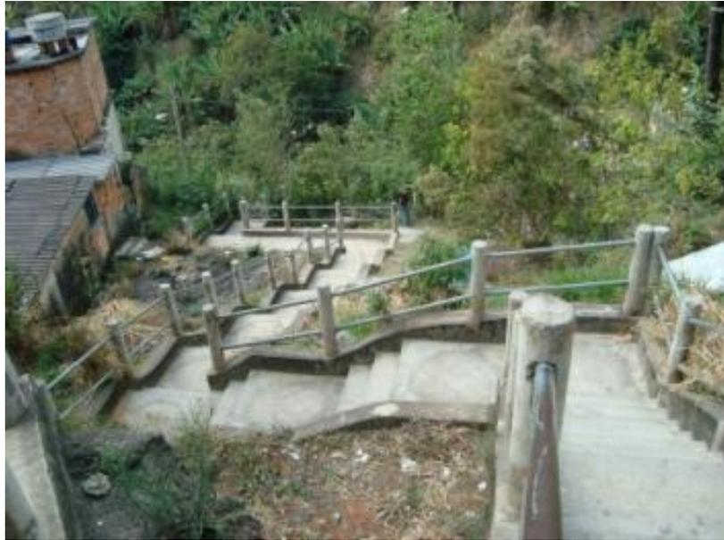
Figura 17 - Padrão de urbanização das vias de pedestres, utilização de elementos pré-moldados - Beco Sem Nome. (10/09/2013).
