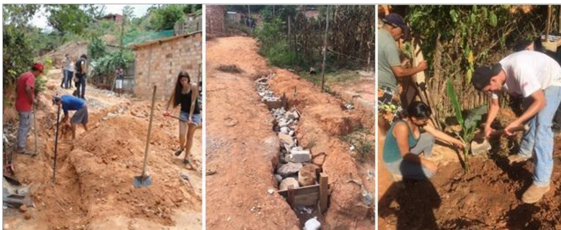
Figura 8 - Alunos e moradores em mutirões na Ocupação Esperança, execução da vala de drenagem e círculo de bananeira na Rua Bela
